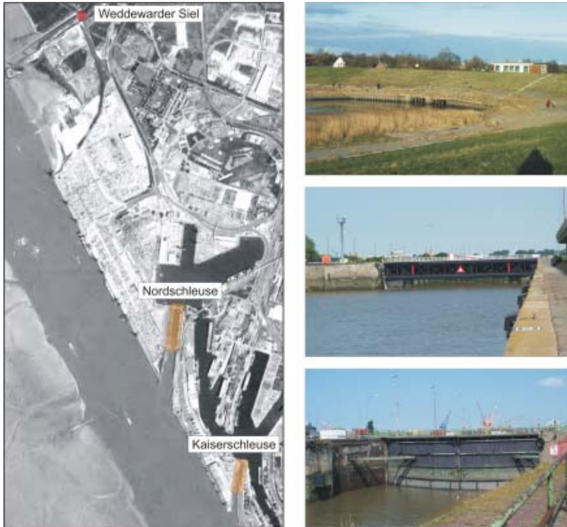
Abbildung 4-38: Übersicht über die punktuellen Schutzelemente an der Bremerhavener Küste nördlich des Pegels Bremerhaven-Alter Leuchtturm: Luftbild [Quelle: SCOUT SYSTEMS] und Photographie (oben: Weddewarder Siel [3469260/5940680], Mitte: Nordschleuse [3470240/5937760], unten: Kaiserschleuse [3470850/5936350])
