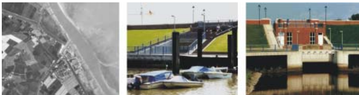
Abbildung 4-34: Informationen zu dem Siel bei Fedderwardersiel [3457320/5940780]: Luftbild [Quelle: SCOUT SYSTEMS] und Photographien
