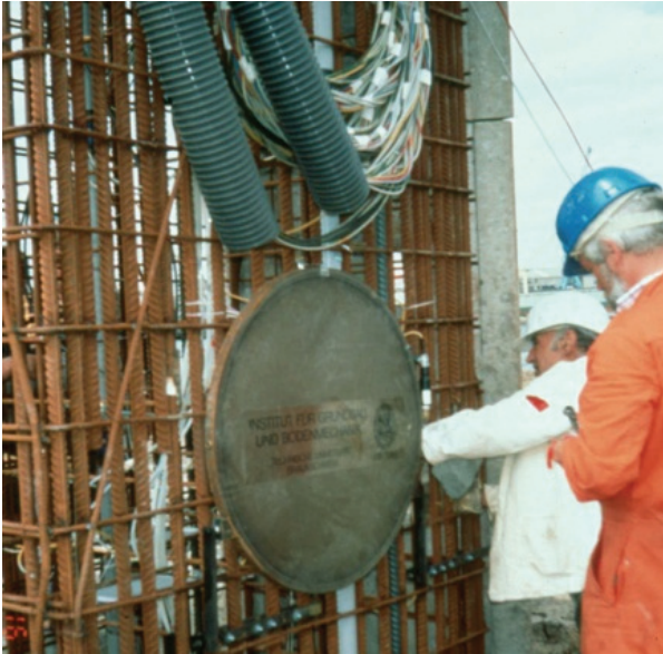
Abb. 7: Ansicht des großen Totalspannungsgebers ( \varnothing 80 cm) [GATTERMANN et al., 2010]
