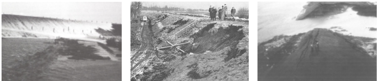
Abb. 1: Stufen eines Deichbruchs infolge Wellenüberlauf: Wellenüberlauf, Erosion der Binnenböschung und Deichbruch (Husum-Verlagsgesellschaft 1993, Kramer, 1997, Wieland, 1990)
