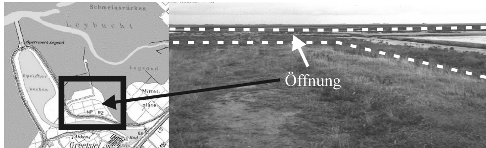
Abb. 11: Teilweiser Abtrag des Sommerdeichs der Hauener Hooge (Aufnahme S. MAI, Dezember 1995)
