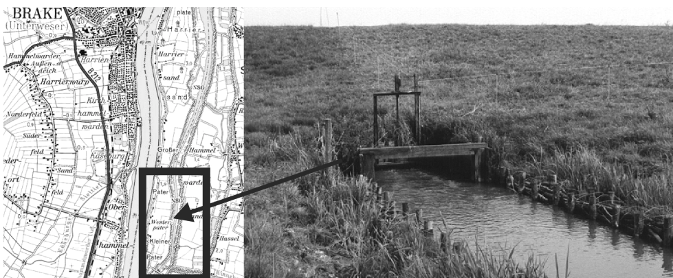
Abb. 9: Lage und Rohrdurchlaß zu einem Sommerpolder auf Harriersand
