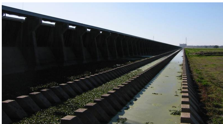
Abb. 9-11: Wehrbauwerk mit Tosbecken am BONNET CARRÉ SPILLWAY (links) und Öffnung des Entlastungsgerinnes im März 1997 (rechts)
