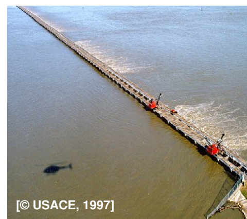
Abb. 9-11: Wehrbauwerk mit Tosbecken am BONNET CARRÉ SPILLWAY (links) und Öffnung des Entlastungsgerinnes im März 1997 (rechts)
