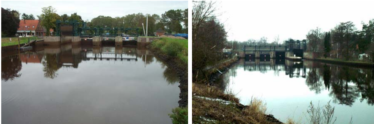
Abbildung 3-15: Ritterhuder Sperrwerk: von unterstrom (links), von oberstrom (rechts)
