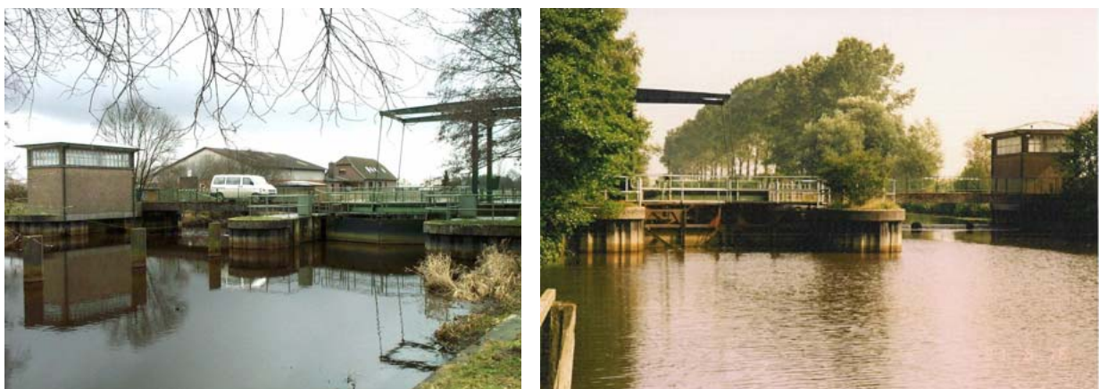
Abbildung 3-14: Teufelsmoorschleuse: von unterstrom (links), von oberstrom (rechts)
