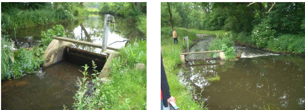
Abbildung 3-17: Stauwehr und Sohlabsturz in der Fintau
