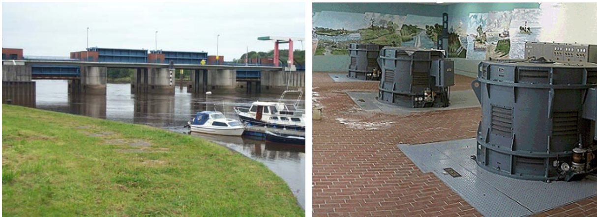
Abbildung 3-2: Lesumsperrwerk (Bild links) und im Schöpfwerk des Lesumsperrwerks installierte Pumpen (Bild rechts) [Deichverband Rechtes Weserufer, 2003]
