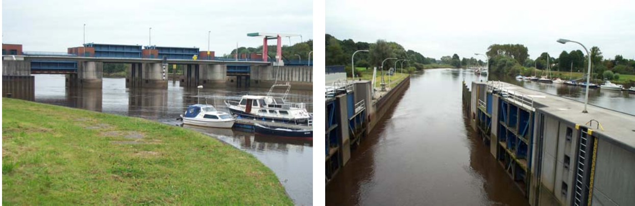
Abbildung 3-16: Wehrfelder und Schleuse des Lesumsperrwerks
