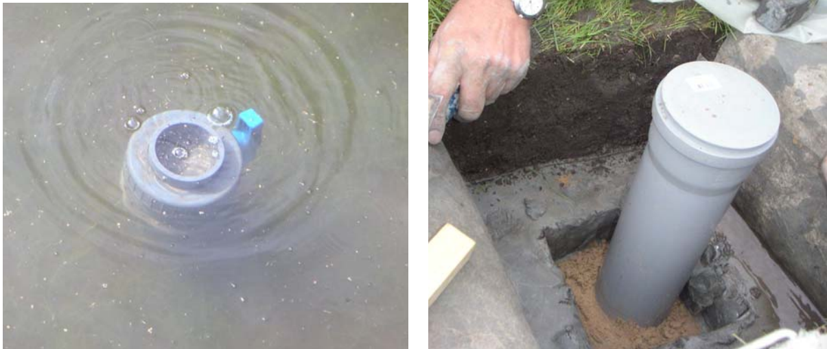
Abbildung 5-13: Steuerbare (links) und weitere nicht steuerbare Öffnungen in der wasserseitigen Böschung des Deichs (rechts) während des Einstaus bzw. während des Einbaus
