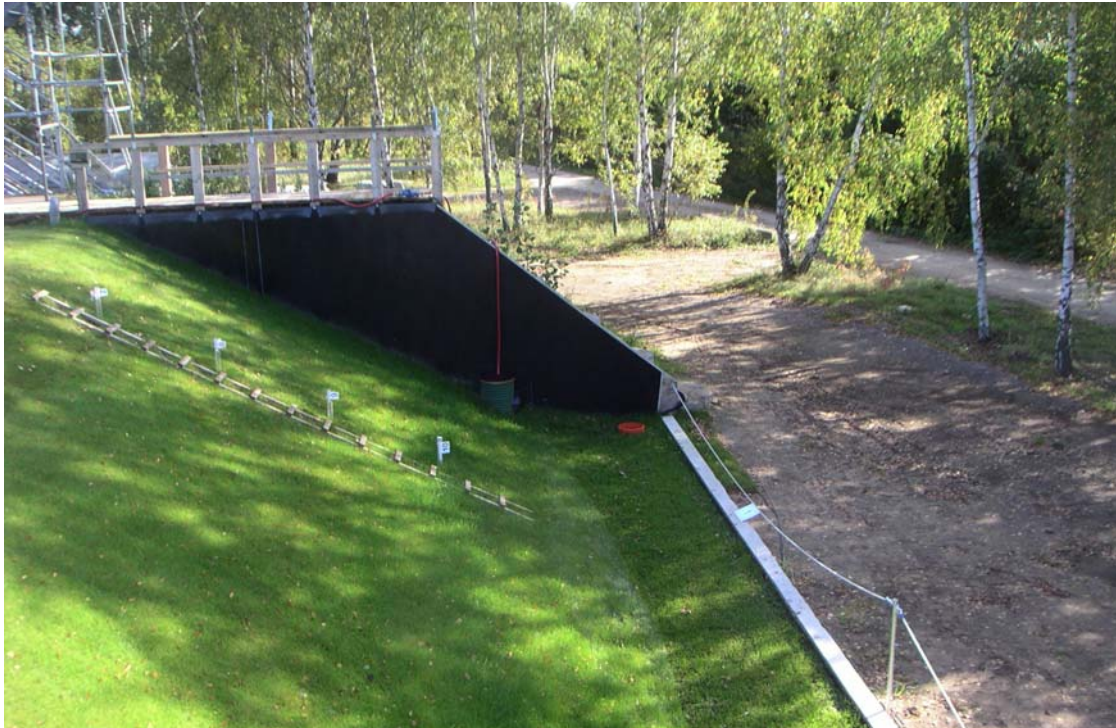
Abbildung 5-21: Ansicht des Deichs nach Beendigung der Versuchsreihe 3 - 27.09.2004 - optimale äußere Bedingungen - komplette Durchsickerung
