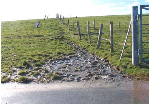
Abbildung 2-18: Kahlstellen durch Schaftritt an einem Zaun (links) und an einem Pfahl (rechts) auf der Binnenseite eines Deiches [Fotos: NLWKN, 2005]
