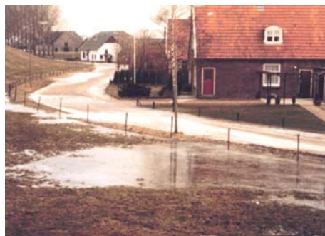
Abbildung 2-13: Durchsickerung nach hydraulischem Grundbruch [Foto: Ministry of Transport, Public Works and Watermanagement, 1982]
