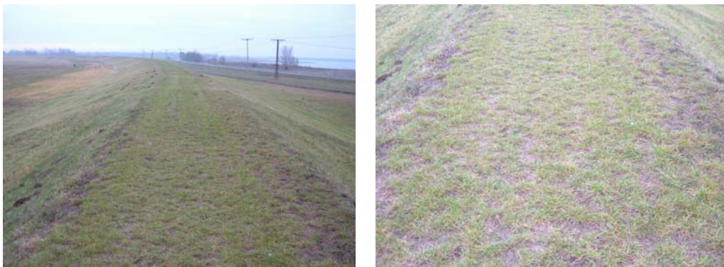
Abbildung 4-5: Fotodokumentation des Muldedeichs: Blick über den Deichverlauf (links) und Detailaufnahme der Deichkrone (rechts)
