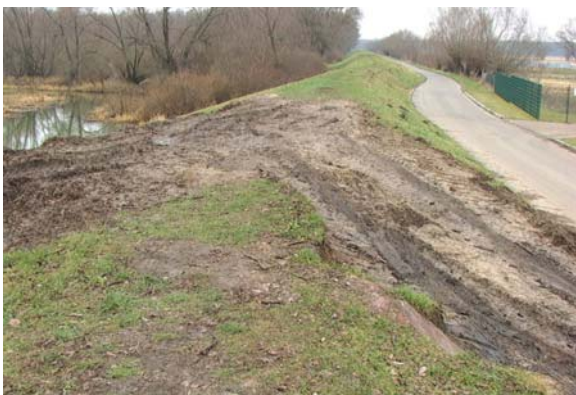
Abbildung 2-19: Fahrspuren (links) und Maulwurfbefall (rechts) an einem Deich [Fotos: NLWKN, 2005]
