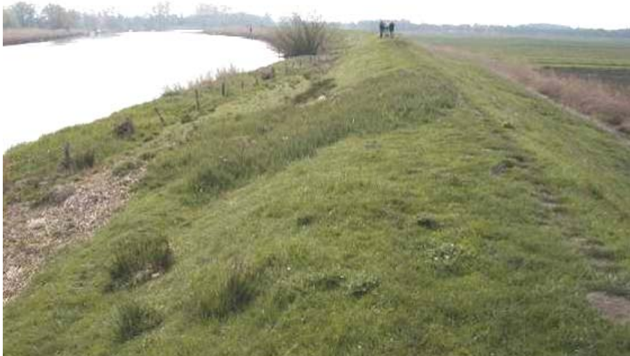
Abbildung 2-22: Wildbewuchs an einem Deich [Foto: NLWKN, 2005]
