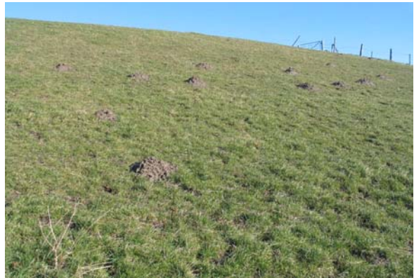
Abbildung 2-19: Fahrspuren (links) und Maulwurfbefall (rechts) an einem Deich [Fotos: NLWKN, 2005]
