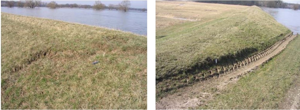
Abbildung 4-4: Fotodokumentation von Anomalien (links: Scharrstelle von Wildtieren, rechts: Deichüberfahrt)
