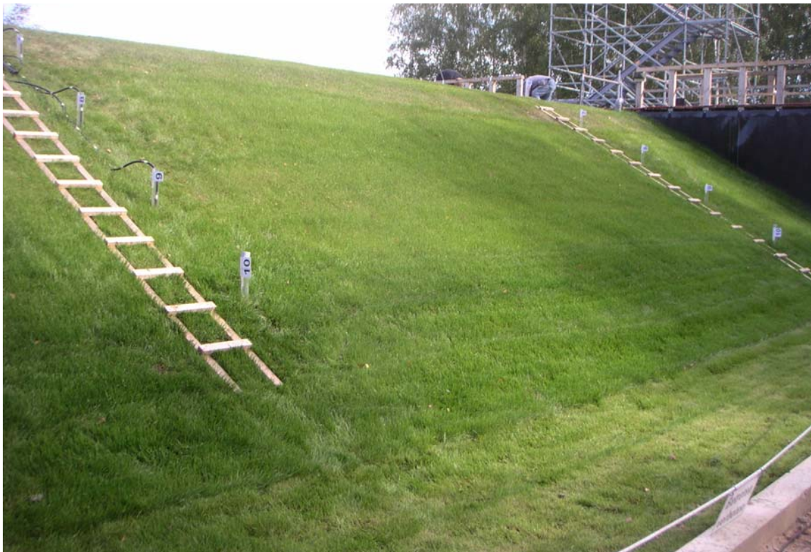
Abbildung 5-12: Ansicht der Luftseite des Deichs nach Beendigung der Versuchsreihe 2 - 23.08.2004 - optimale äußere Bedingungen - geringe künstliche Schädigung
