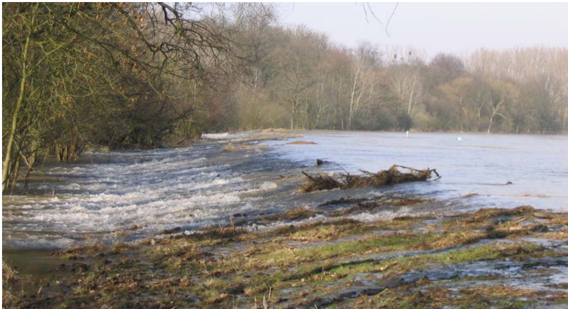
Abbildung 2-17: Überströmen eines Elbdeichs [Foto: Kokemüller, 2005]
