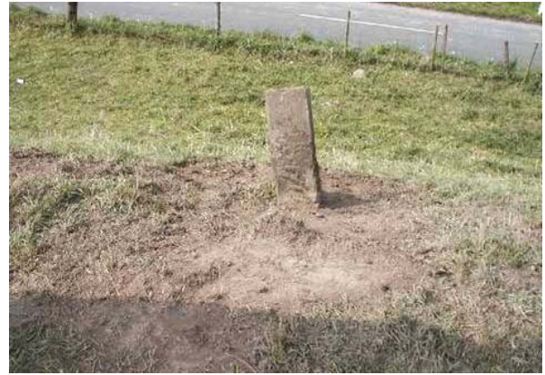
Abbildung 2-18: Kahlstellen durch Schaftritt an einem Zaun (links) und an einem Pfahl (rechts) auf der Binnenseite eines Deiches [Fotos: NLWKN, 2005]
