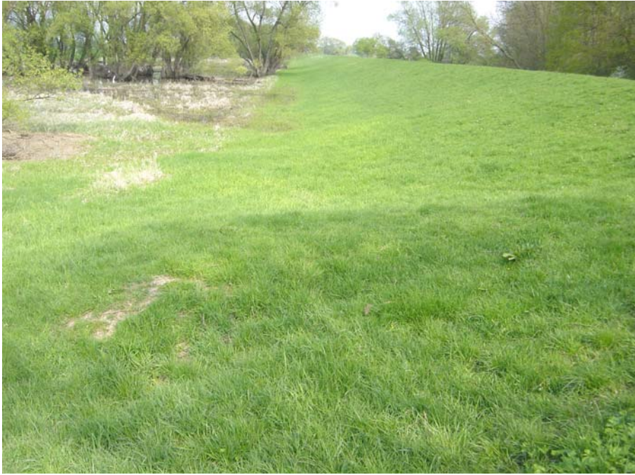
Abbildung 4-33: Großflächige Geländeerhöhung auf der Deichböschung
