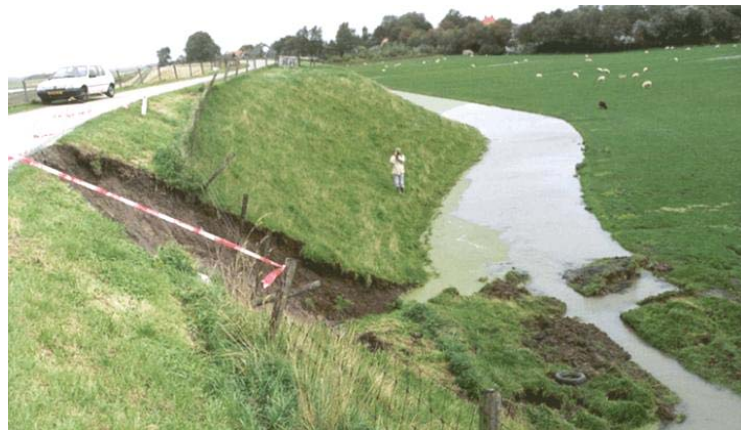
Abbildung 2-7: Böschungsgrundbruch in der Natur [Foto: Internationale Kommission zum Schutz der Elbe, 2004]
