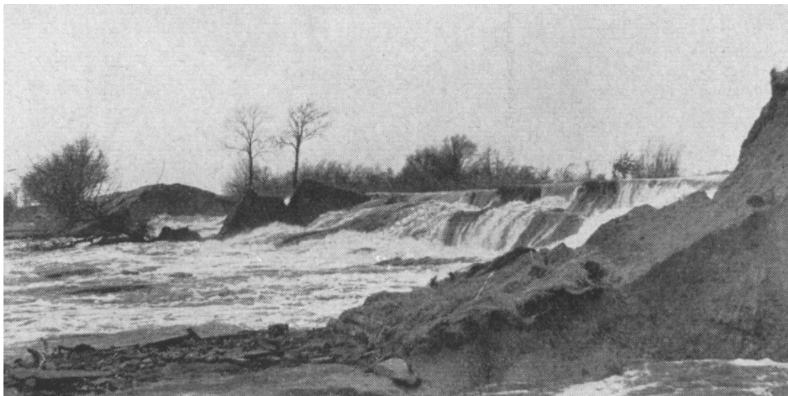
Abbildung 2-1: Wellenüberlauf und Ausspülungen in der Krone eines Deiches [EAK, 1993]
