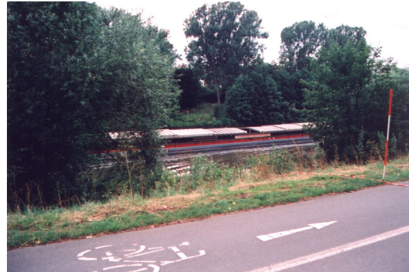
Abb. 2-2: Vorgesehene Einleitungsstelle am Ostufers des km 6,2 des Main-Donau-Kanals
