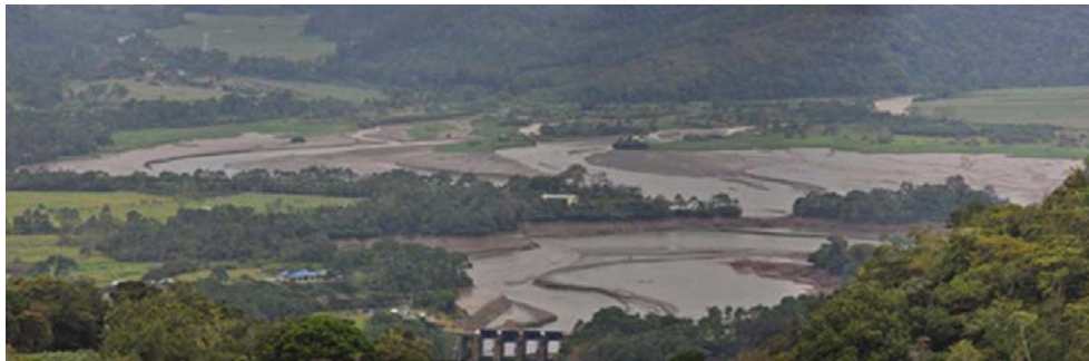
Abbildung 3 Angostura Speicher während der Stauraumspülung, November 2010
